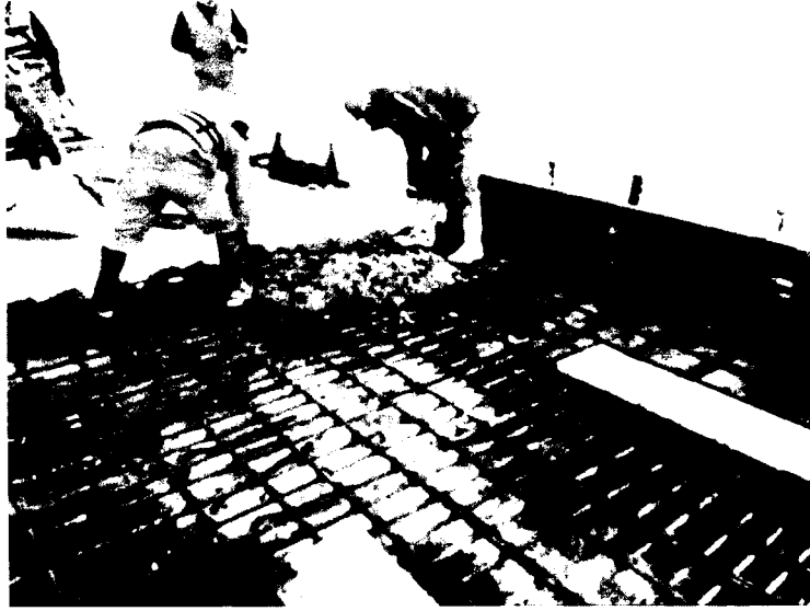
FOTO 05: Vaciado de concreto en losa del día 06/07/19
