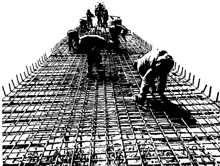
FOTO 01: Armado de acero en losa del día 01/07/19
